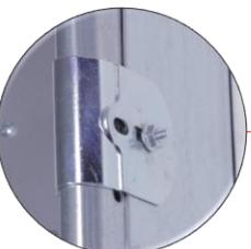
La jonction entre les rails horizontaux et verticaux permet un déplacement fluide de la porte sans présenter de sursaut au passage des roulettes.
